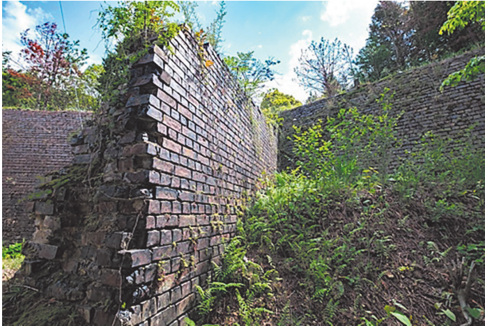
鍛煉瓦の平均寸法は、小口の上辺が120mmで下辺は140mm。長手は上辺270mm、下辺290mm。高さ105mm。これだけ丁寧に造られたものは珍しい。
