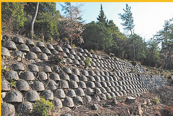
半球型の緩は直径約350mm、高さ約250mm。運び廃棄しやすいように半球型にした例はあるが、大規模な再利用例は帯江鉱山だけかもしれない。
